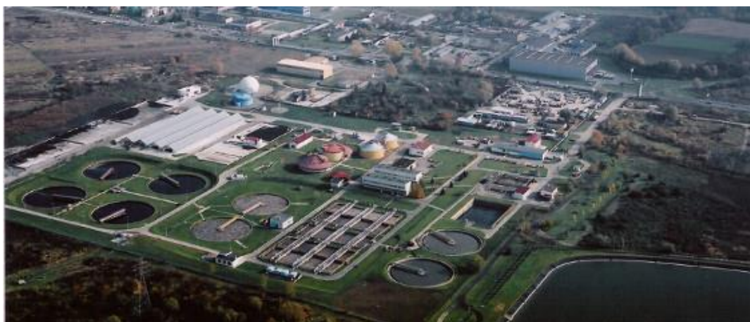
Fot. 6 Oczyszczalnia Ścieków dla miasta Rzeszowa 60
