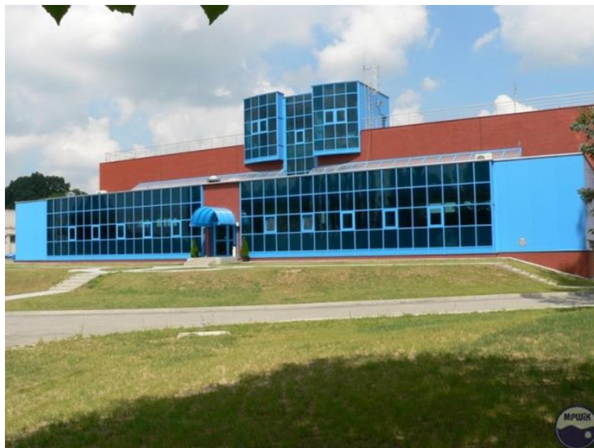
Fot. 5 Zakład Uzdatniania Wody dla miasta Rzeszowa 57
